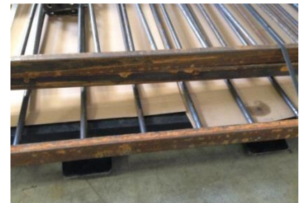
2. Rost auf Geländerelement
