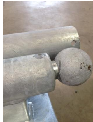
3. Weißrost auf verzinktem Geländerelement
